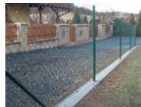
Usazení naležato ve štěrkovém podloží
